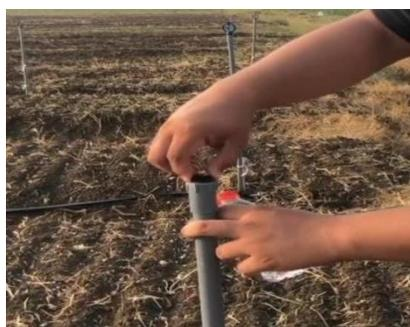
Gambar 3. Pemasangan *sprinkler* pada pipa ukuran ½ inci
